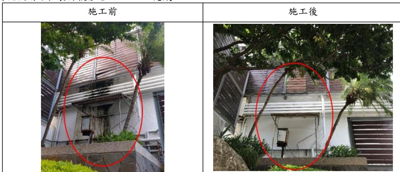
3. S 棟北側木工房屋頂修繕，109/9/3 更新受潮屋頂及完成型鋼除鏽及油漆。
