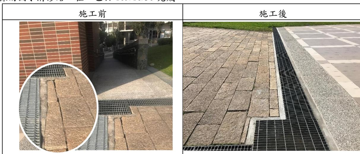
17.P2 車道出入口處攔水閘門鐵件凸起修繕，已於 109/11/17 完成。
